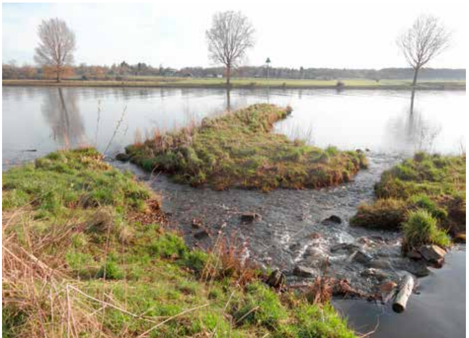
Monding Oeffeltsche Raam voor herinrichting met drempel, krib, breuksteen en grind.
